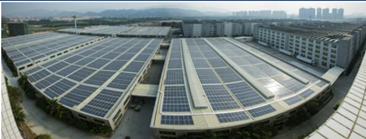
图 25：敏华惠州工厂光伏发电
